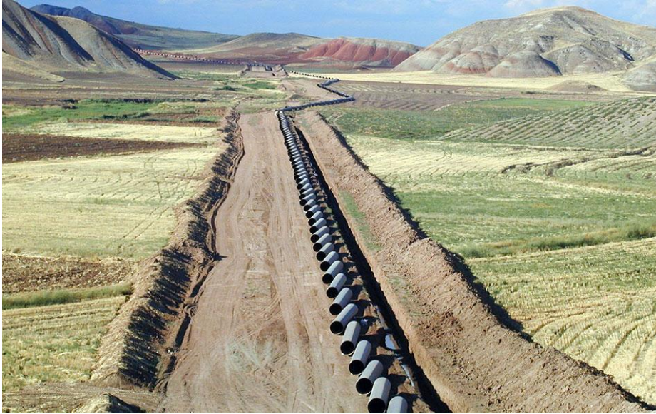
Boru Hattı İnşaatı
